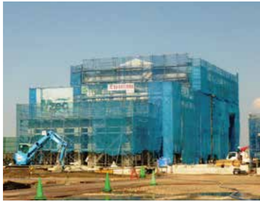
建設中の横須賀バイオマス発電所
